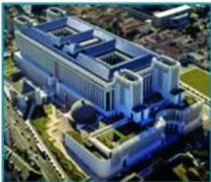
Figura 1 - Vista aérea da Caixa geral de Depósitos, edifício sede
