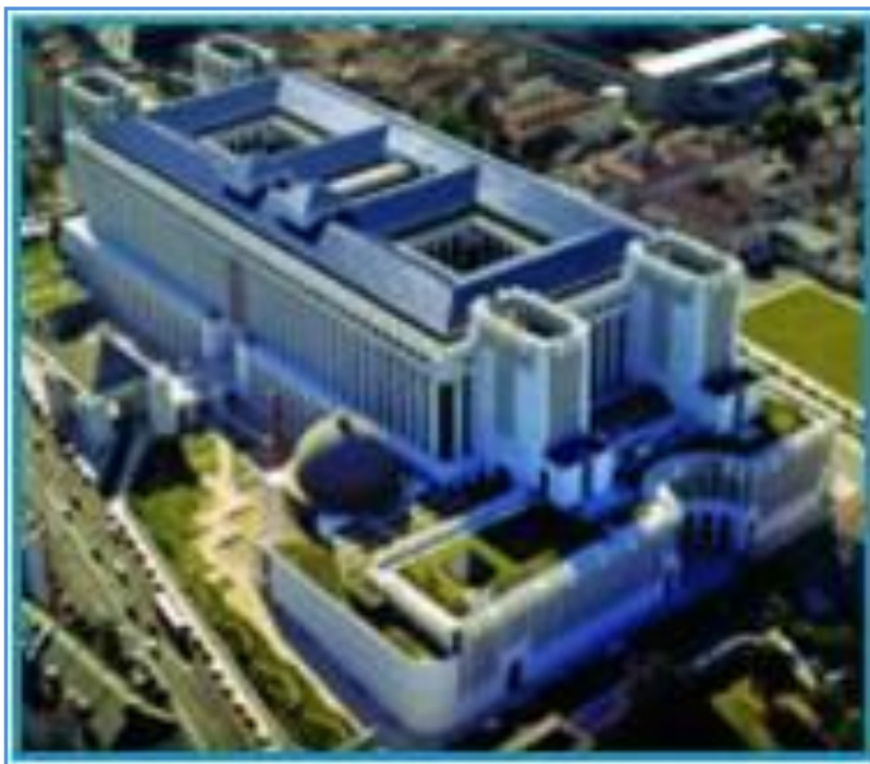
Figura 3.1 Vista aérea da Caixa Geral de Depósitos, Edifício Sede [9]
